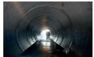
运河和井道工程
