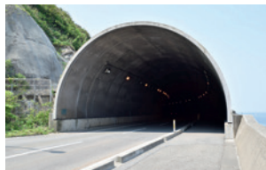
隧道和混凝土管道
